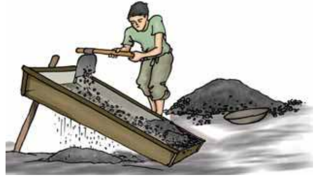
चित्र 5.7 चालन द्वारा कंकड़ तथा पत्थरों को रेत से पृथक किया जाता है
